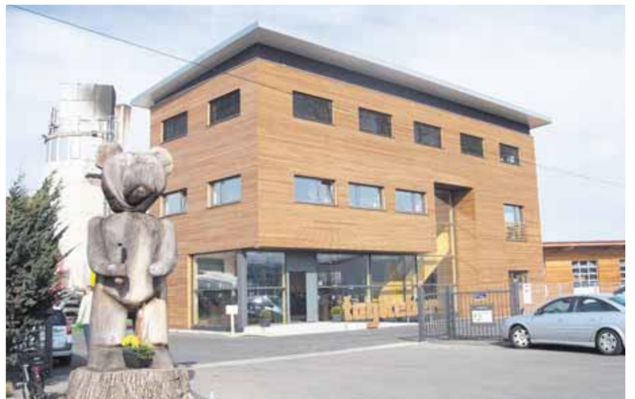
198 Kubikmeter Holz und 230 Kubikmeter Hanf wurden für das 606 Quadratmeter große neue Bürogebäude mit Ausstellungsflächen der Oettinger Firma Taglieber verbaut. Standortausbau und Werbung zugleich, denn das Haus wurde in Passivhausbauweise errichtet und steht für die ökologische Orientierung der Firma. Fotos (2): heja
